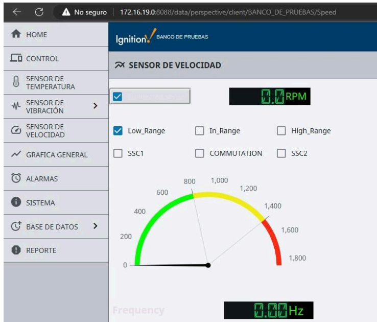
Figura 22. Visualización de la sección de SENSOR DE VELOCIDAD en el sistema SCADA.
